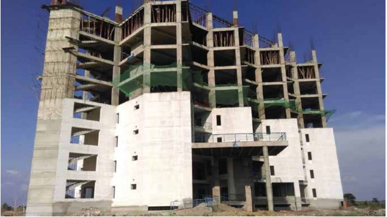
নির্মাণাধীন ১০-তলা অফিস ভবন, বারটান সদর দপ্তর, আড়াইহাজার
